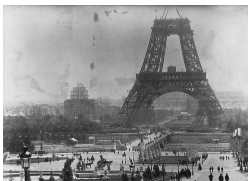
Párizs: az Eiffel-torony építése
